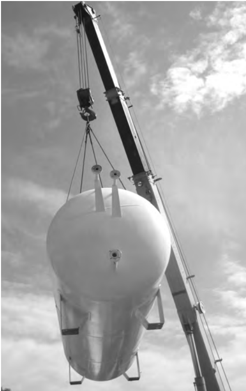
Погрузка надземной емкости для СУГ V-10 м 3 производства «Газовик-Химмаш»
