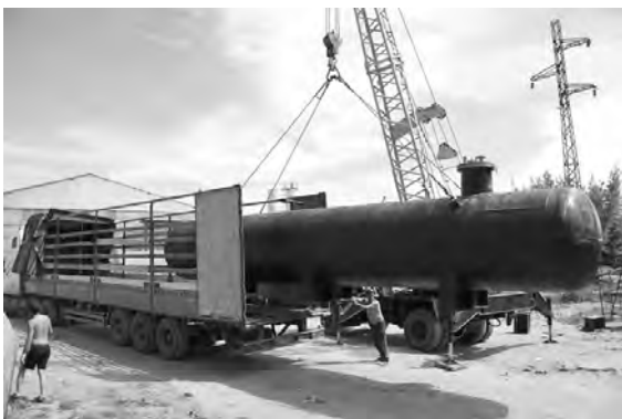
Габаритный груз: погрузка подземной емкости для СУГ V-25 м 3 производства «Газовик-Химмаш»
