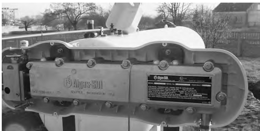
Рис. 11.17. Вид испарителя «Zimmer» со снятой задней крышкой
